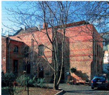
200 Tonnen Schutt beseitigt und komplett entkernt: In einem Kraftakt wurde das Gebäude 2003 in ein Wohnhaus umgebaut. Chr. Schröder
